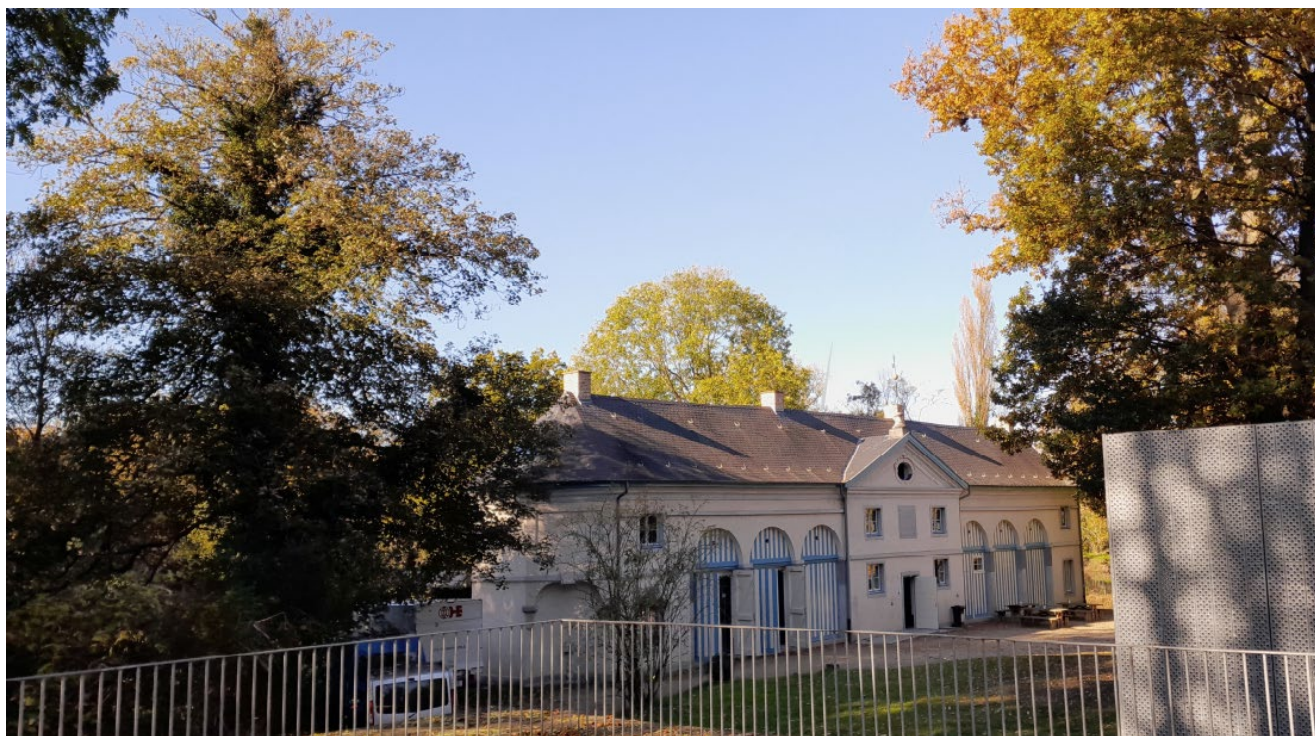
Zicht ter hoogte van de Abdij van Roosendaal
