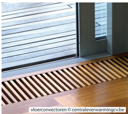
vloerconvectoren © centraleverwarmingcv.be
