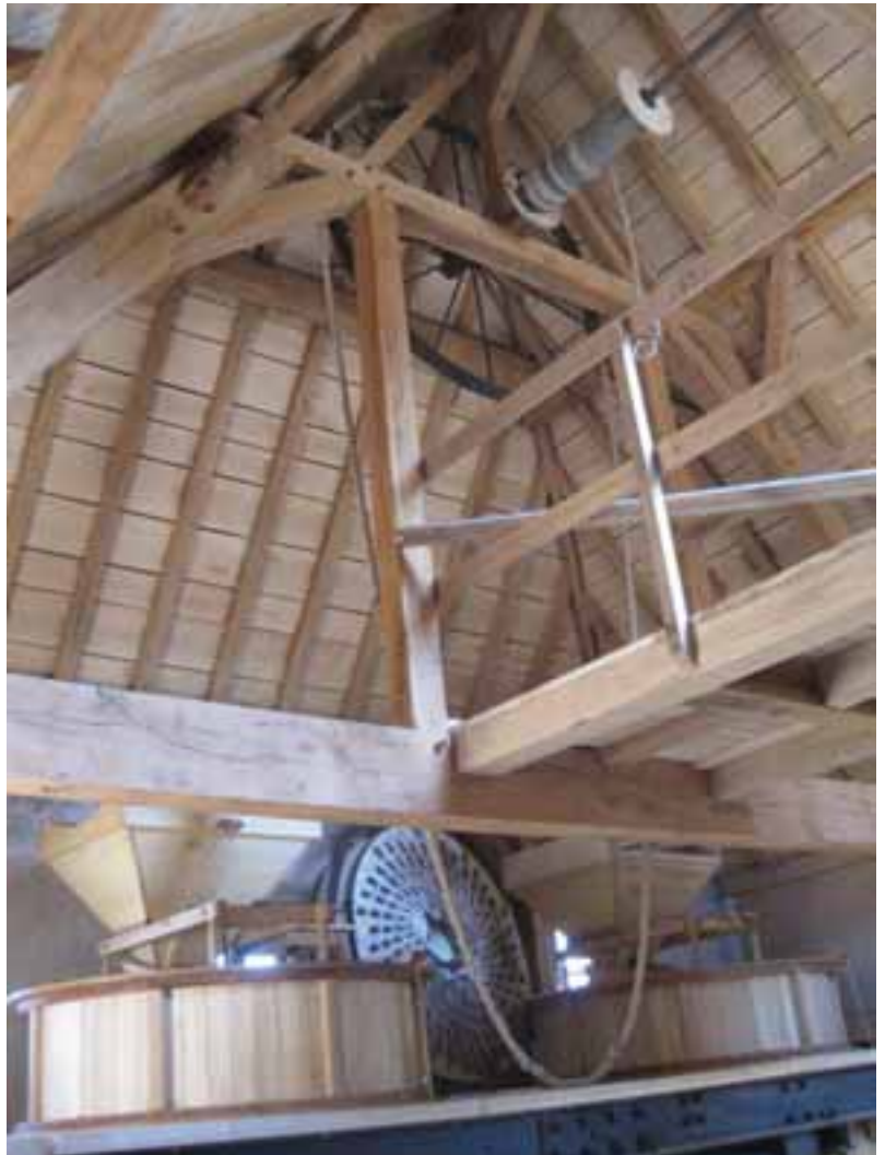
Binnenzicht van de Molen van Schoonhoven. Een kleine watermolen, waar de Motte voor waterkracht zorgt. Ecopower investeerde in een waterwiel met generator. Maar ook het binnenwerk werd gerestaureerd, zodat deze molen nu ook weer graan kan malen.
