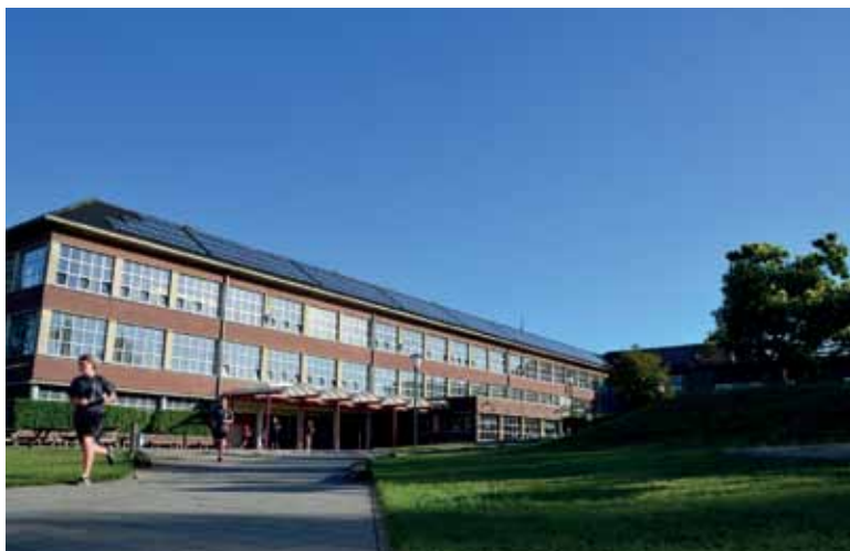
Op 121 scholen, verspreid over heel Vlaanderen, heeft Ecopower zonnepanelen geïnstalleerd (foto Ecopuur).
