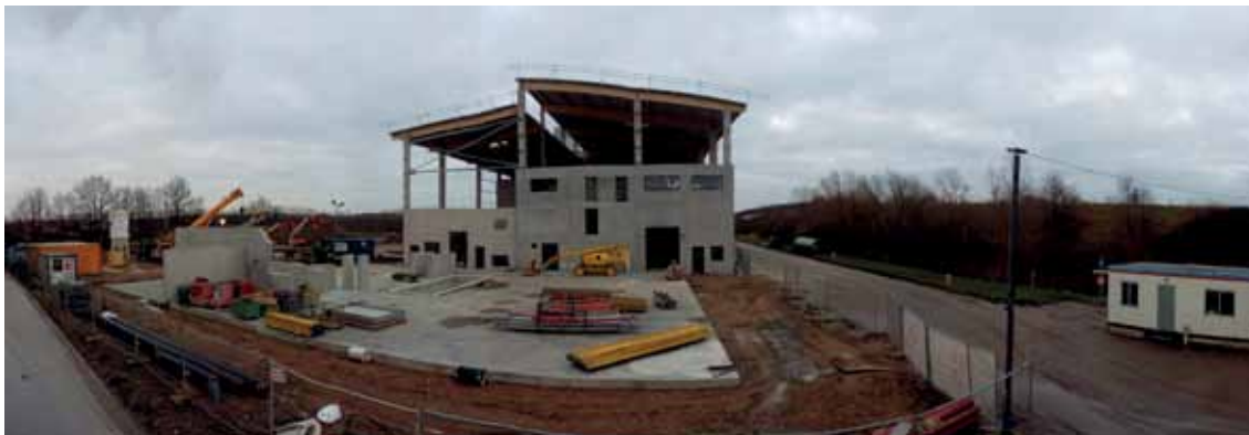
26 december 2013: het dak staat erop
