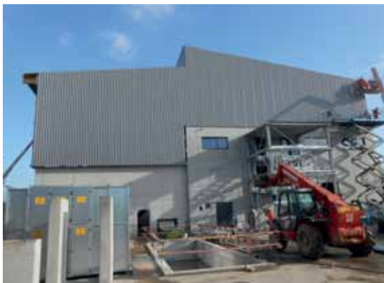
24 januari 2014: beplating kantoorzijde
