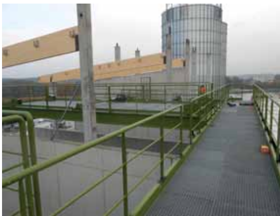
26 november 2013: silo's en dakconstructie
