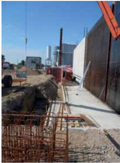
3 oktober 2013: betonnen muren
