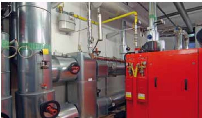
Evenwichtsfles werd tussen beide delen geplaatst.
