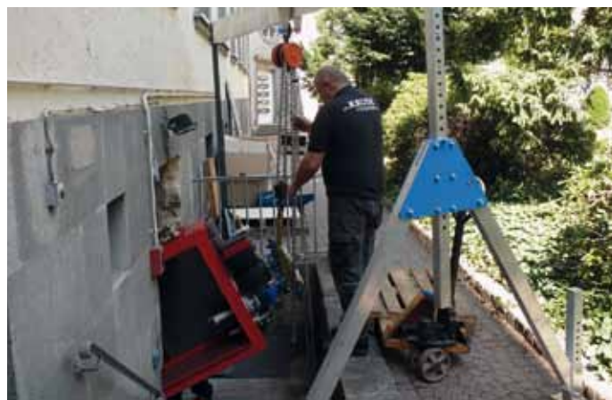
Montage warmtekrachtkoppeling te Ministerie
