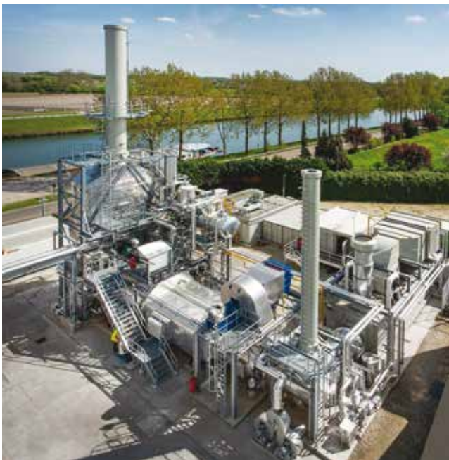
Figuur 5 Industriële WKK met een gasturbine en recuperatiestoomgenerator (foto: WKK van E.ON bij Promat)
