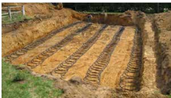
Figuur 33: Uitvoeringsvormen van horizontale bodemwarmtewisselaars.
