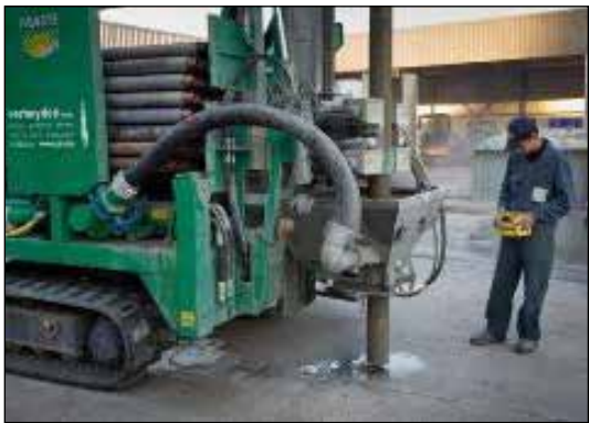
Figuur 35: Uitvoeren van een verticale bodemwarmtewisselaar.
