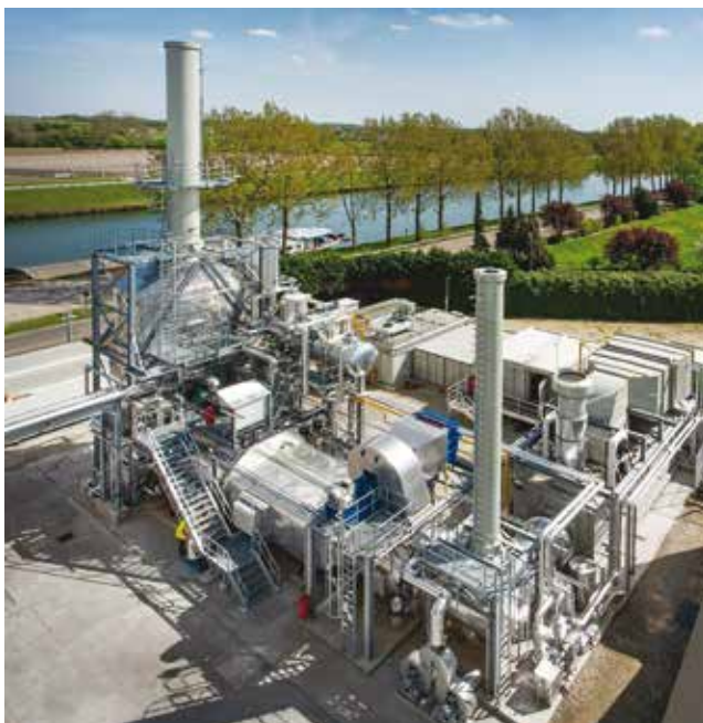
Figuur 10 Industriële WKK met een gasturbine en recuperatiestoomgenerator (foto: WKK van E.ON bij Promat)
