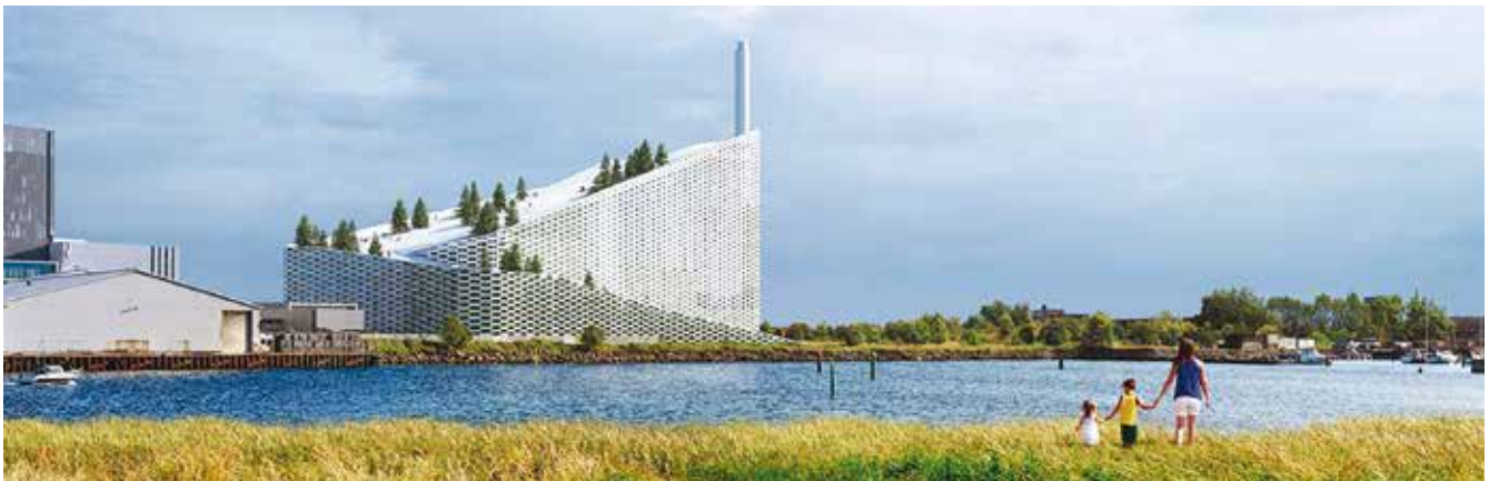
Copenhagen: het dak van de WKK van de afvalverwerkingsinstallatie in Copenhagen is een skipiste
