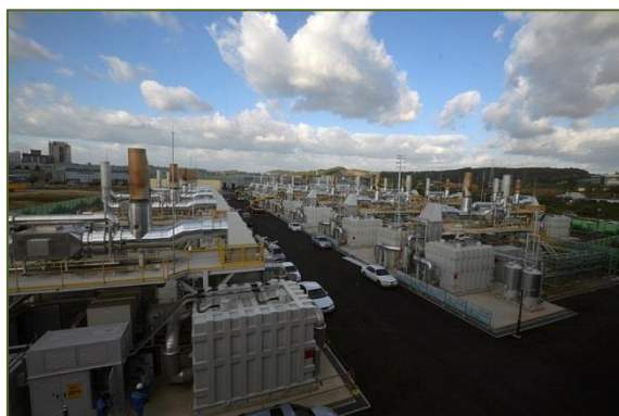
Figuur 15: De grootste brandstofcel-WKK centrale staat in Zuid-Korea op slechts 2 ha en levert warmte voor een warmtenet en 59 MW elektriciteit.
